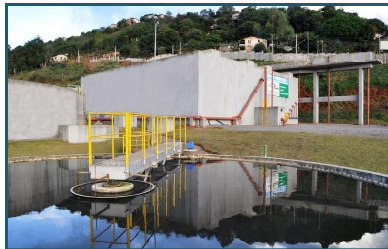
Estação de Tratamento de Esgoto (ETE) CANYON Sistema parte Separador Absoluto e parte Parcialmente Unitário
