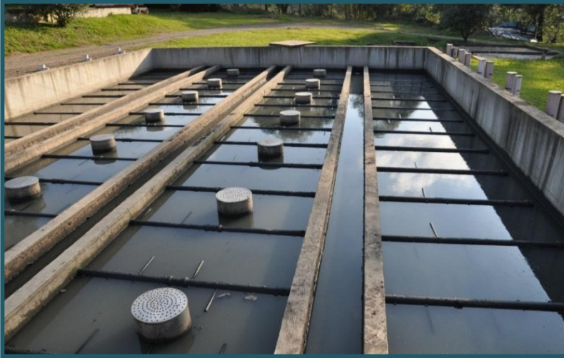
Estação de Tratamento de Esgoto (ETE) RIVADÁVIA GUIMARÃES – SERRANO Sistema Separador Absoluto
