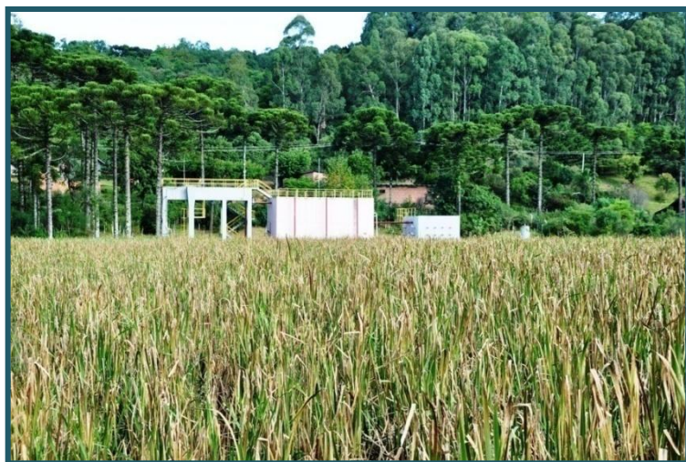
Estação de Tratamento de Esgoto (ETE) ANA RECH Sistema Separador Absoluto
