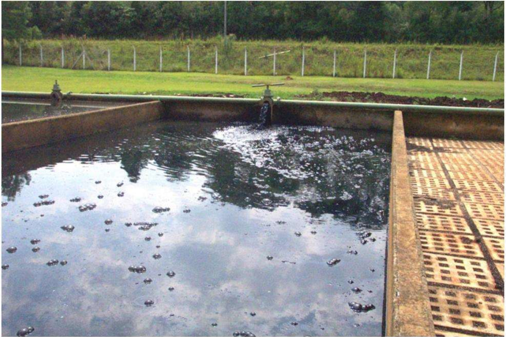
Figura – Lodo anaeróbio de reator UASB, estabilizado, descarregado em Leito de Secagem
