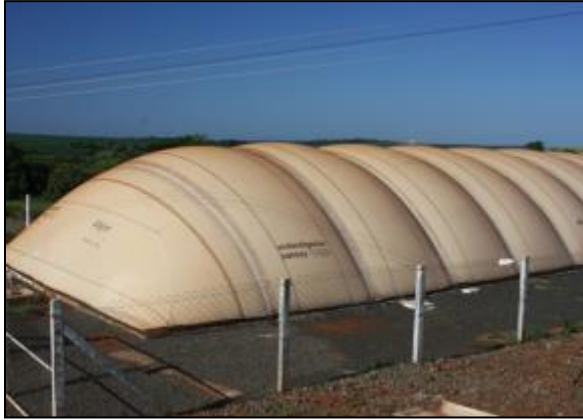
Sistema tipo lagoa coberta Aplicação: resíduos agrícolas
