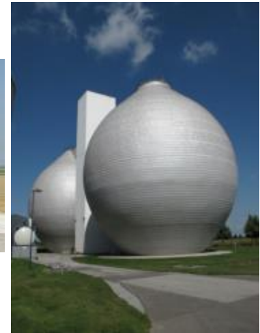
Sistema tipo formato de ovo Aplicação: lodo de esgoto
