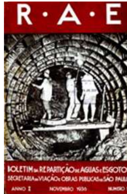
O GAZ DOS ESGOTOS (1936) Autores: Jesus Netto, J.P.
