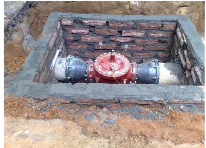
Foto 5 - Caixa de Alvenaria Executada para a VRP
