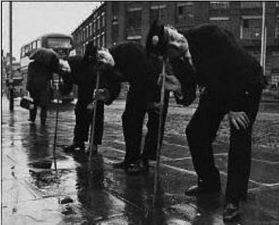
Pesquisa de vazamento – Londres 1880.
