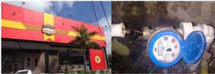
Restaurante e bar com hidrômetro travado com arame
