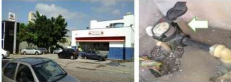
Posto de combustível com hidrômetro travado com super ímã
