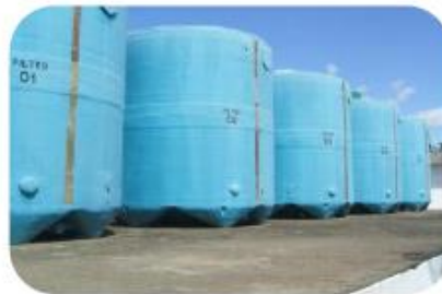
Vista lateral dos filtros da ETA compacta
