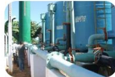
Detalhe das tubulações na ETA compacta
