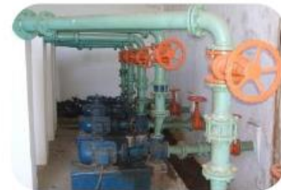
Conjunto de motor-bombas de recalque do Reservatório Apoiado (RAP-02) para o Reservatório Elevado (REL-01)
