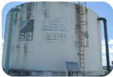
Reservatório Apoiado (RAP - 01)
