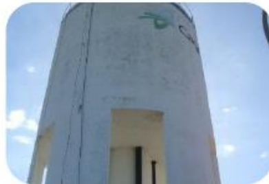
Reservatório Elevado principal (REL-01)
