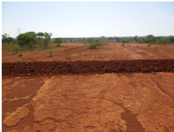
Construção de terraço
