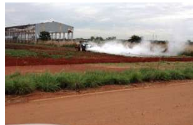
Aplicação de cal hidratada
