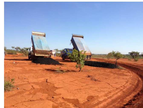
Descarregamento de lodo
