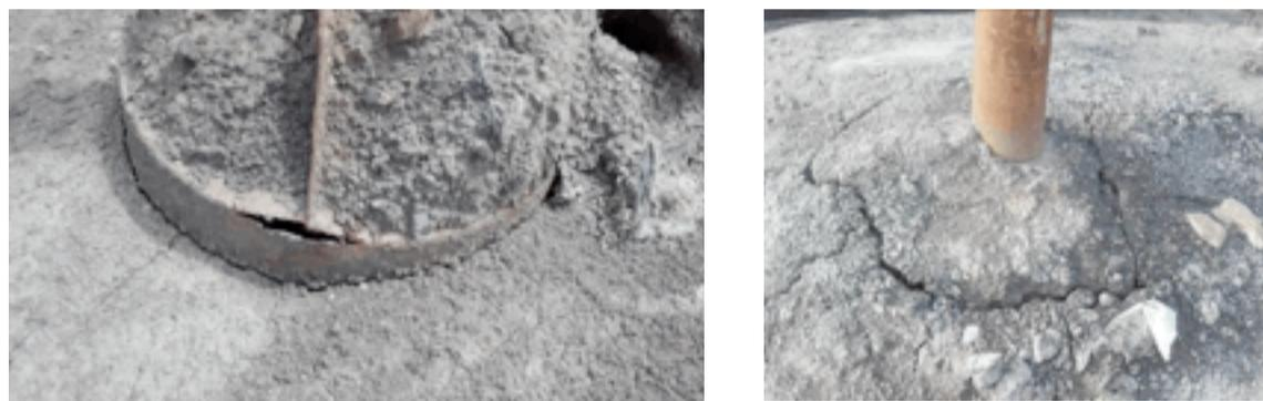
Figura 8 a e b – Fuga pelo biogás pelo dreno danificado e trincas no solo
